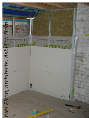
Retour d'isolant sur le mur de refend.
