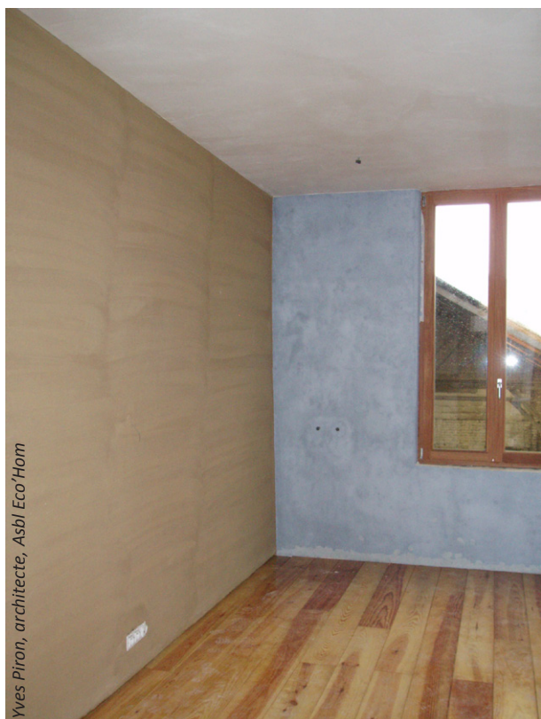
Enduit chaux-chanvre au fond et enduit à l'argile à gauche. Enduit à l'argile.
