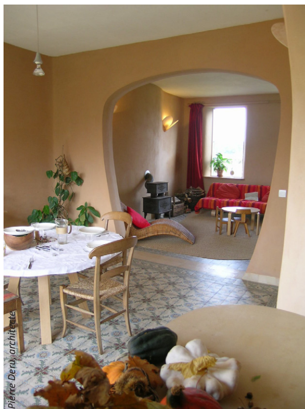
Enduit chaux-chanvre au fond et enduit à l'argile à gauche. Enduit à l'argile.
